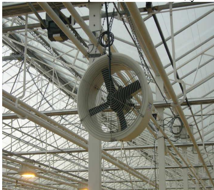
Вентиляторы для дополнительной циркуляции воздуха в теплице
