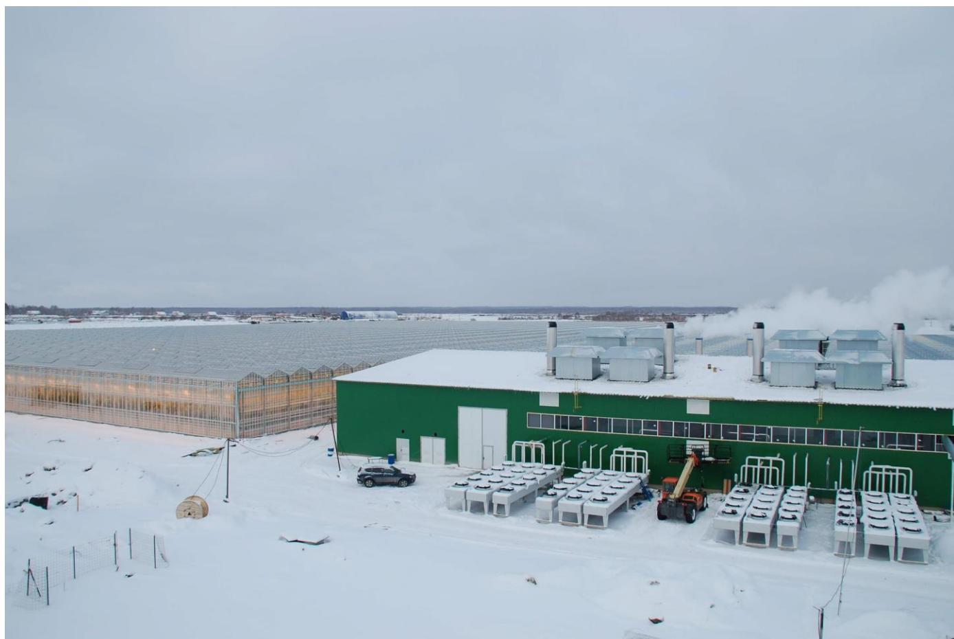
Котельная мощностью 40 Мвт
